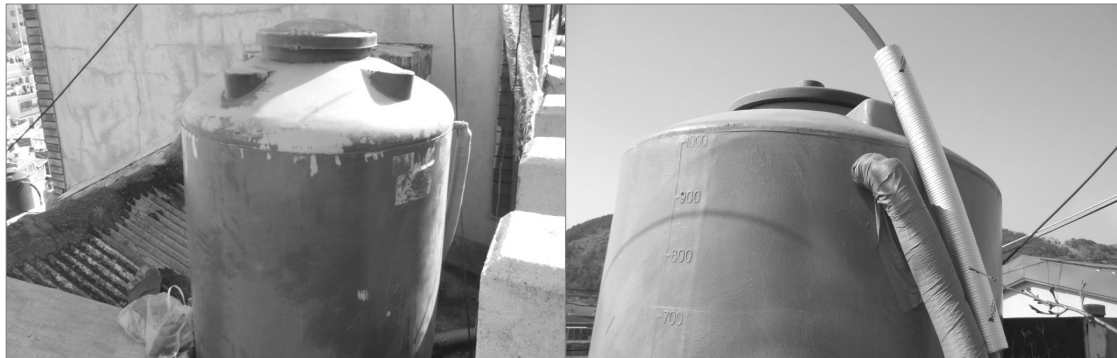
그림 2. 옥상 물탱크 설치
